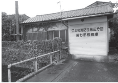
撤去予定の消防格納庫の塀
