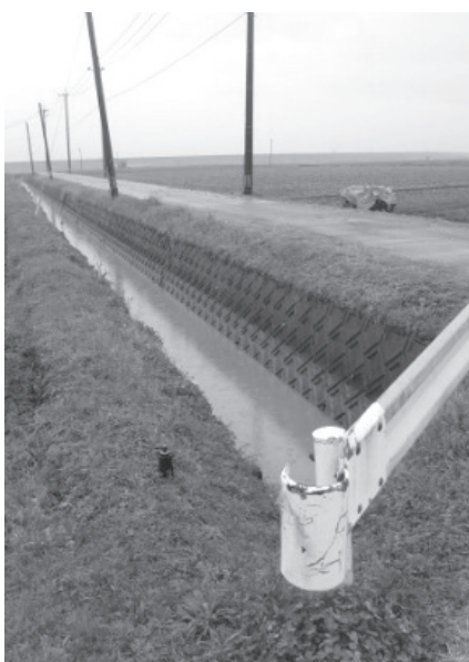
ガードレール未設置の堤防跡の農道
