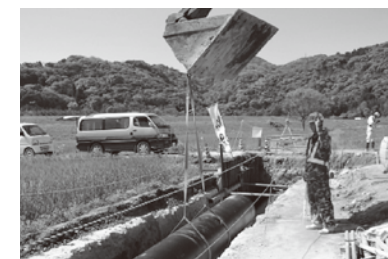
パイプラインの施工状況
