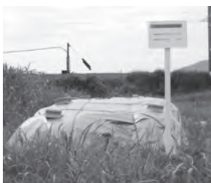
積土のうの状況
