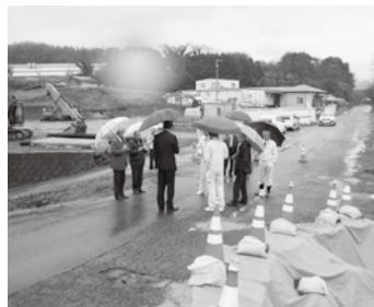
畑川水路災害現場
