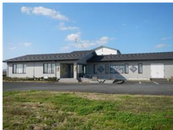
【終末処理場】 名称：江北クリーンセンター 位置：江北町大字八町2170 竣工：平成15年3月 処理方式：嫌気好気ろ床法 処理能力：2,488m 3 /日
