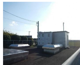
【ポンプ場施設】 名称：祖子分汚水中継ポンプ場 位置：江北町惣領分3341番地2 竣工：平成11年3月 処理能力：2.00m 3 /分
