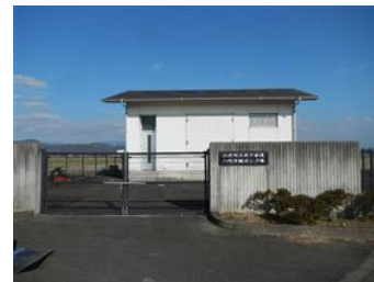
【ポンプ場施設】 名称：八町汚水中継ポンプ場 位置：江北町大字八町1049番地2 竣工：平成15年3月 処理能力：0.30m 3 /日
