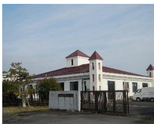
【終末処理場】 名称：佐留志クリーンセンター 位置：江北町大字惣領分13番地 竣工：平成11年3月 処理方式：回分式活性汚泥法 処理能力：730m 3 /日
