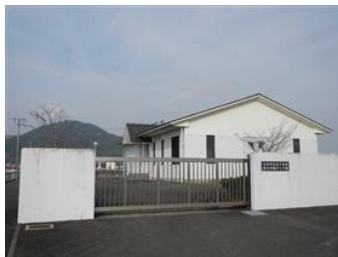
【ポンプ場施設】 名称：東分汚水中継ポンプ場 位置：江北町大字山口320番地3 竣工：平成15年3月 処理能力：2.86m 3 /日
