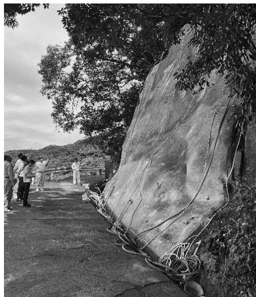
門前安坂線工事現場
