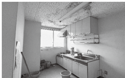
東古川排水施設雨漏り箇所
