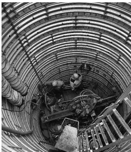
集水井・横ボーリング施工
