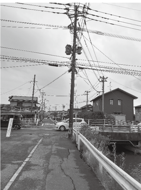
西分農道崩落現場
