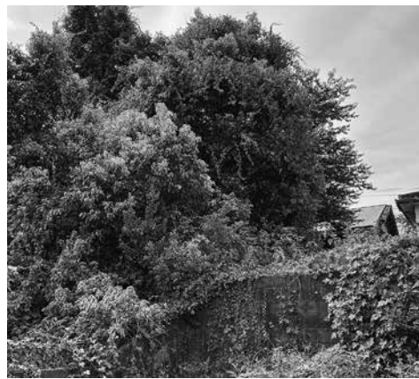
屋根に覆いかぶさっている大木
