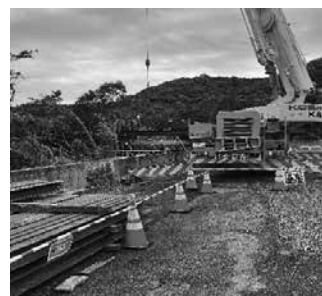
花祭杭打ち現場
