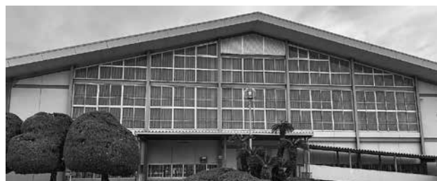
保管場所の小学校体育館
