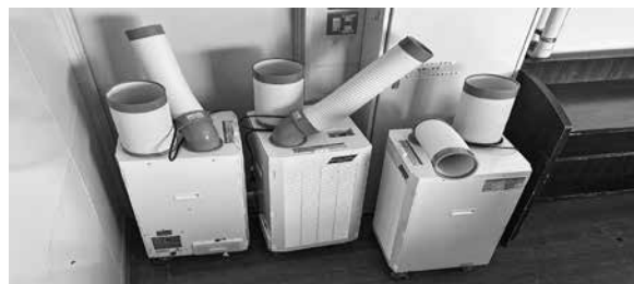
江北小学校体育館の倉庫（スポットクーラー）
