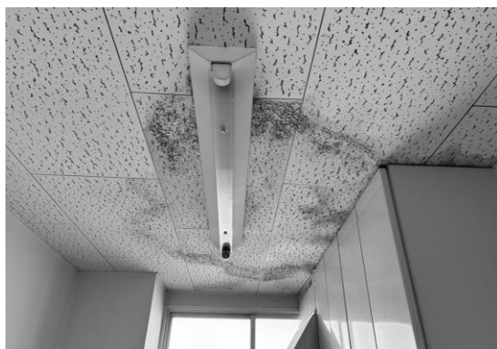
炊事室・操作室 天井修繕工事 7㎡ ・天井板(ジプトン)交換 ・点検口設置
