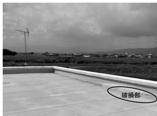
屋上防水工事 50㎡ ・屋根露出防水密着工法 (ウレタン系防水層仕上げ)
