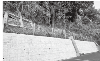
整備が進む地すべり事業の壁面
