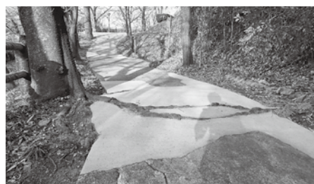
整備された散策路
