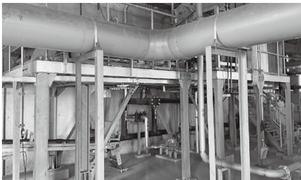
クリーンセンター内部
