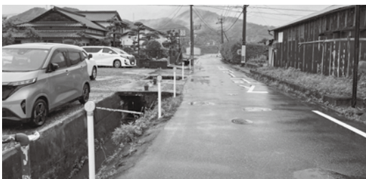
安全対策として反射板が設置された
