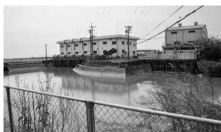
浚渫工事完了 東古川排水機場
