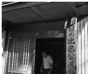
老朽化が進む 公民館
