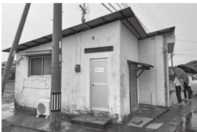
第8部格納庫 老朽化が進み建替え予定
