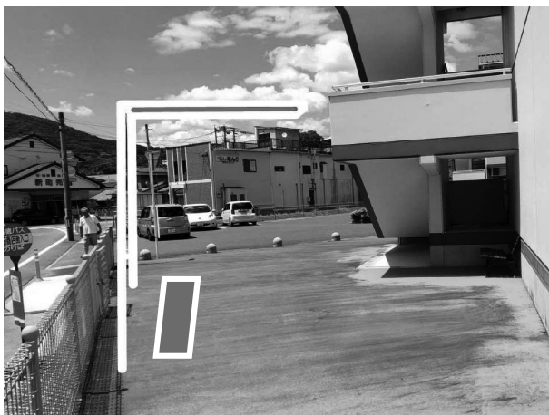
①小田商店街入口(上小田団地前)
