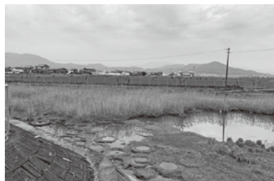
東古川排水施設付近
