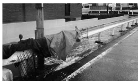
道路工事周辺の水路
