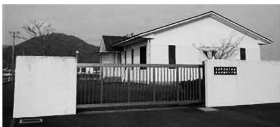
東分汚水中継ポンプ場
