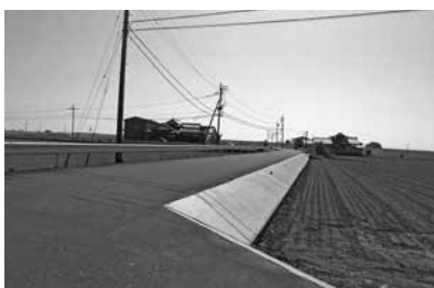
整備された法面
