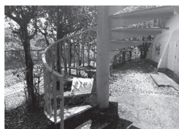
らせん階段の修繕
