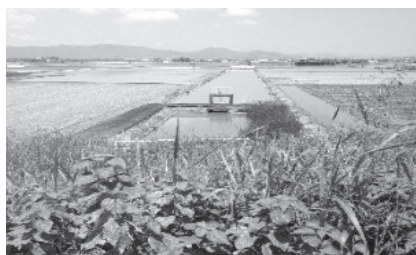
長江湖排水樋管反対側は草が繁茂
