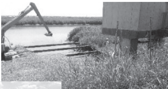
重機を使った浚渫
