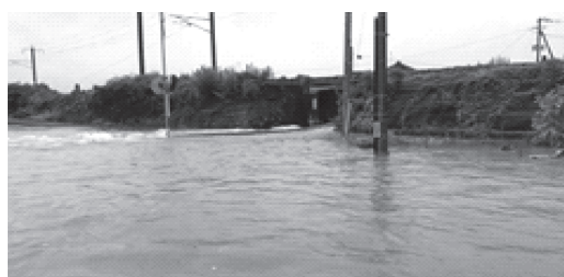
令和3年8月豪雨被害 大西鉄橋付近
