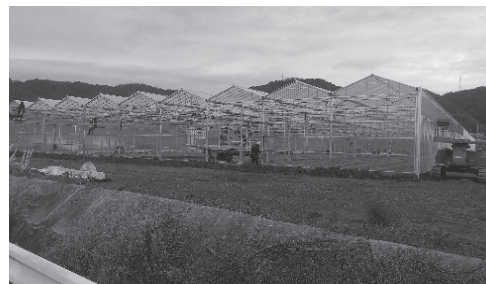
整備中のハウス団地
