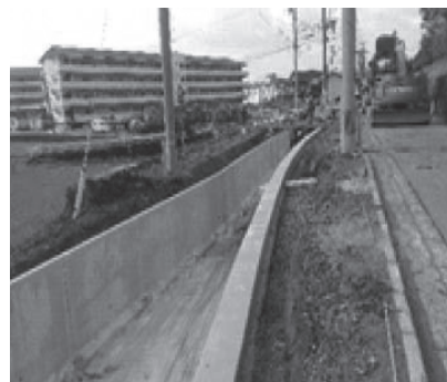
完成間近な水路
