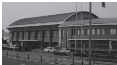
空調が設置されるネイブル
