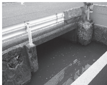
水の流れが心配な水路
