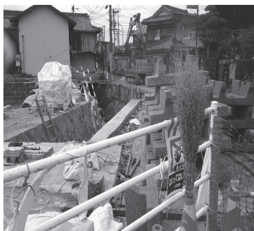
工事中の門前～畑川線
