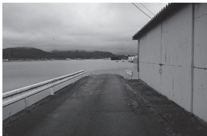
平成29年7月6日降雨被害状況（正徳方面）
