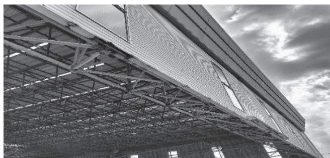
34年前に建設された全天候スポーツ広場
