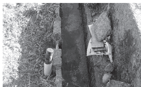
掛け水取水口
