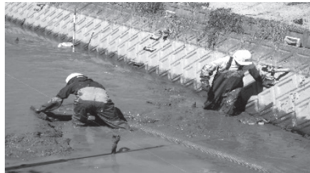
流入した泥土の撤去作業
