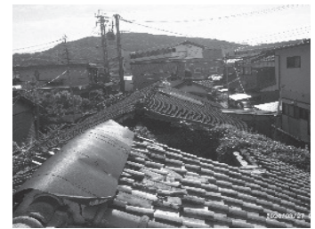
同空家の屋根の状況
