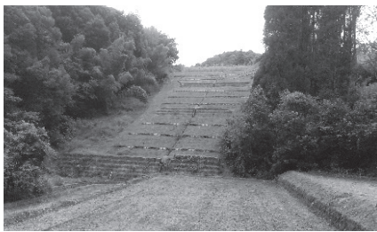
工事完了した花祭ゴルフ場法面
