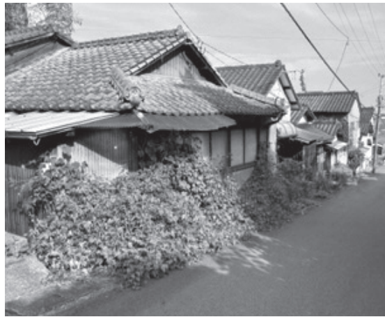
空家が並び、町道にはみ出ている雑草
