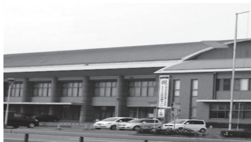
空調の整備が望まれるネイブル
