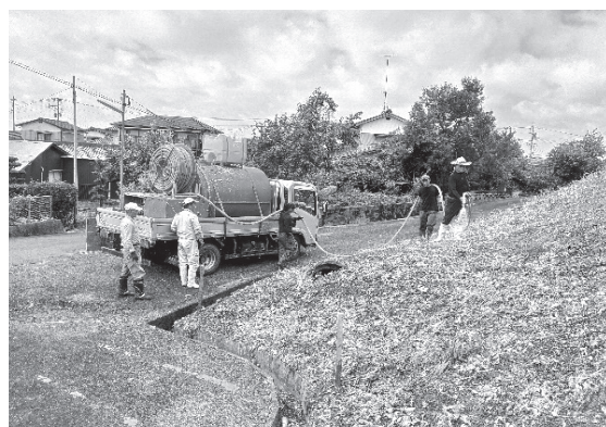
センチピードグラスの種子の吹き付け
