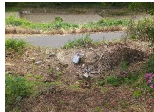
平山 南東部法面
