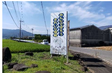
看板改修工事 14.工事請負費:996千円
