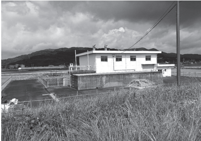
①満神排水機場（小城市）
