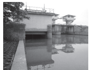
東古川切替ゲート
