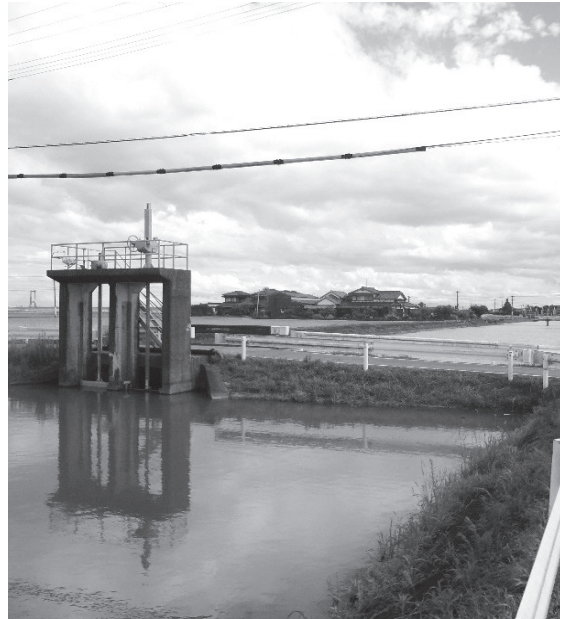
事前落水する幹線水路のゲート
