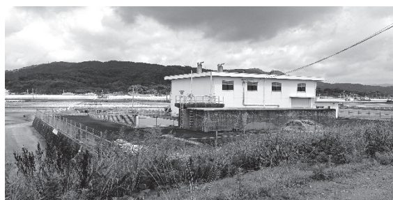
満神排水機場
