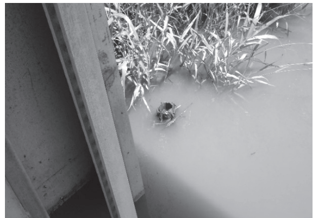
③朽木排水樋管
