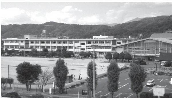
老朽化が進む小学校校舎
