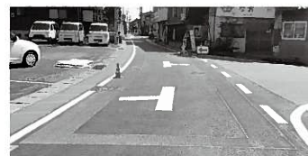
交差点カラー舗装
