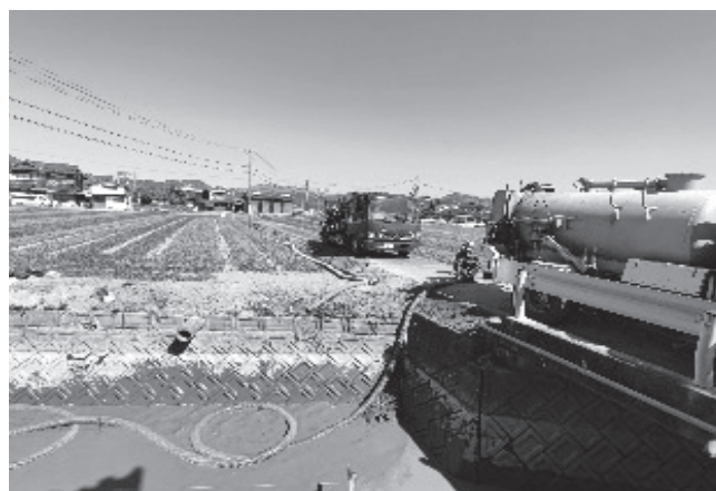
特殊車両による泥土の吸い上げ
