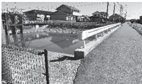
1号水路横（西方向から）
