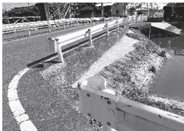
2号水路（西方向から）
