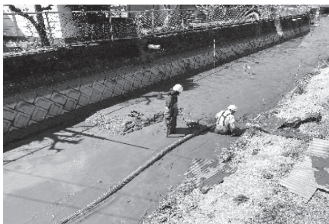
水路に入っの作業の様子
