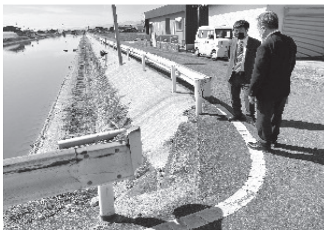
2号水路（北方向から）
