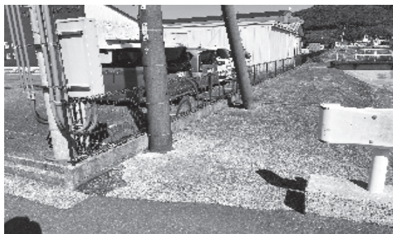
1号水路（南方向から）
