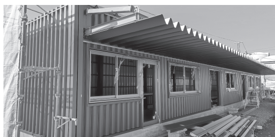
建設中のコンテナショップ
