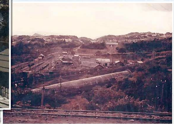
④ 杵島炭鉱第五坑
