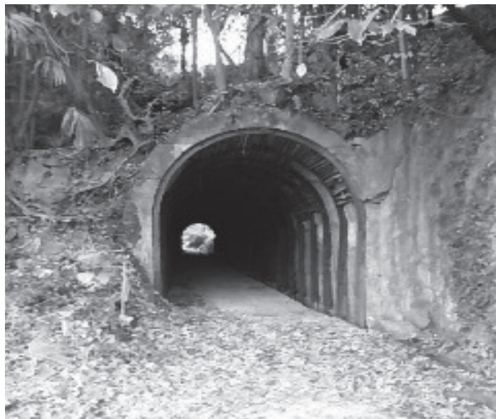
旧岩屋住宅下のトンネル
