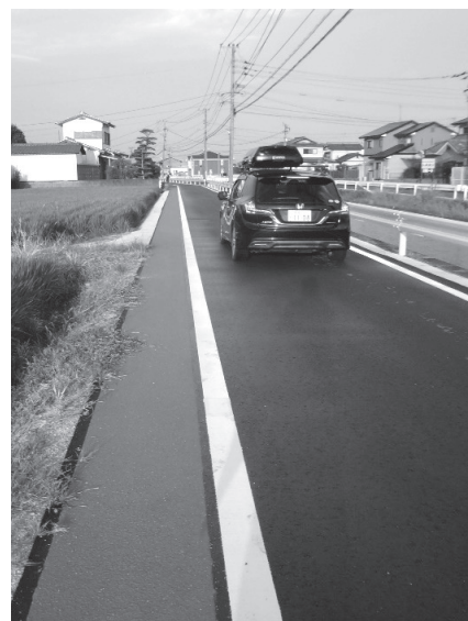
駅南地区羽佐間水路北側の町道 (現道幅員4.5m)
