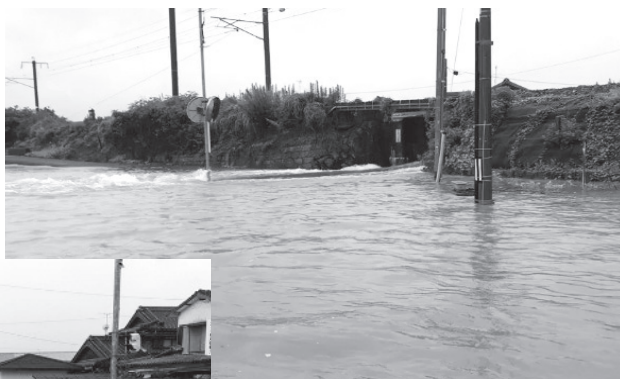
下小田地区冠水被害
