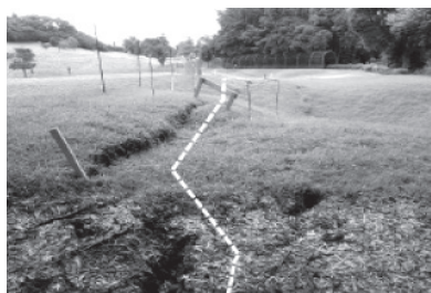
ゴルフ場内被害状況
