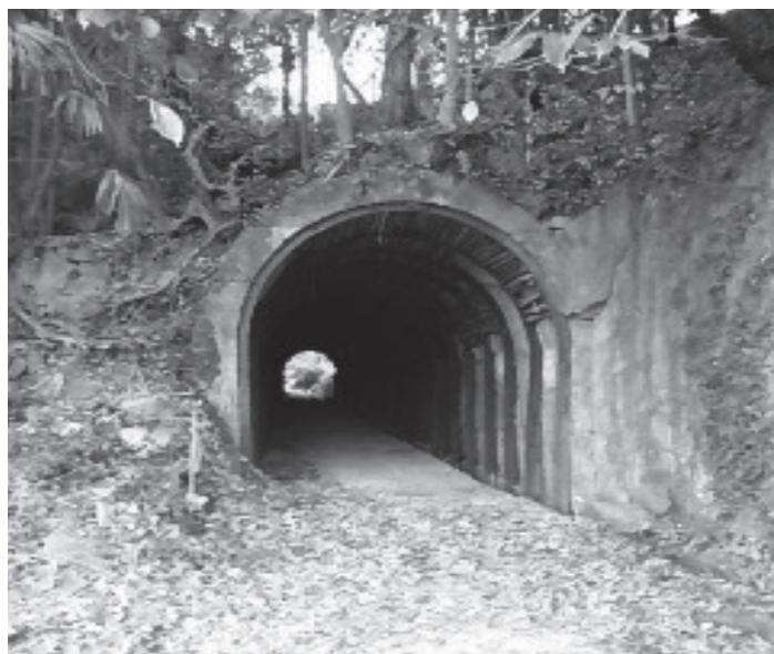
旧岩屋住宅下のトンネル
