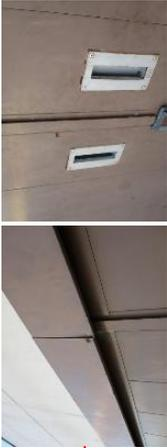
倉庫出入口の細製戸、吊り部カバー及び取っ手周囲に若干のサビ劣化が見られます。特段の変態は無いと思いますが劣化進行防止の対応が望まれます。
