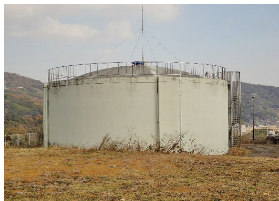
岳受水配水場
