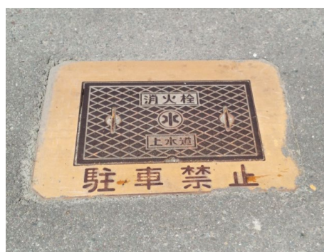
せん 道路にある消火栓
