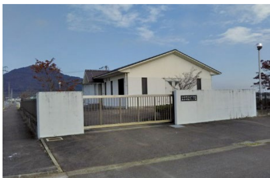
東分中継ポンプ場
