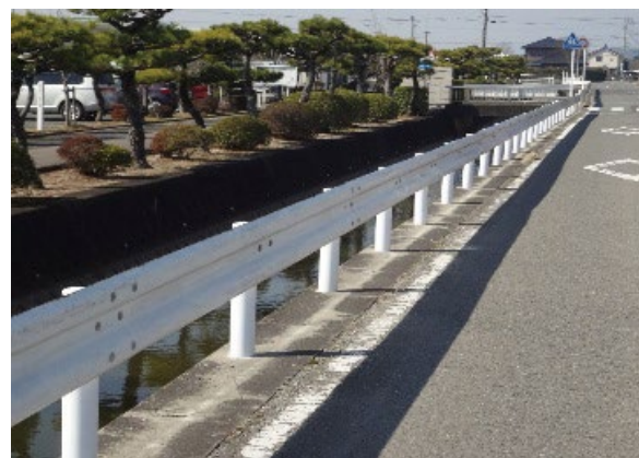
ガードレール
