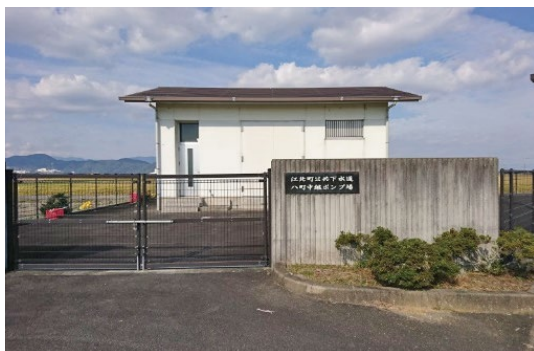
八町中継ポンプ場
