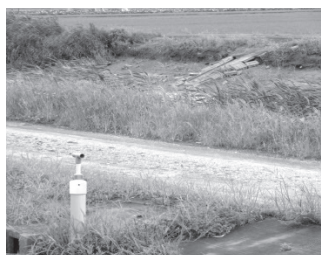
水位調整型水閘（立て水閘）の状況
