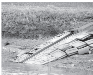
張りブロックと暗渠の現状
