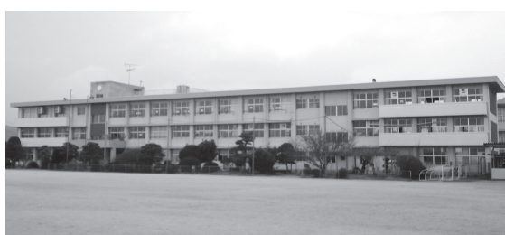
改修が待たれる小学校
