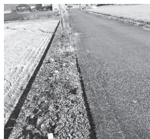
町道のり面状況
