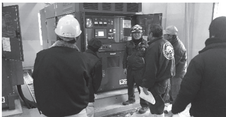
朽木排水機場 電動ポンプへの移行
