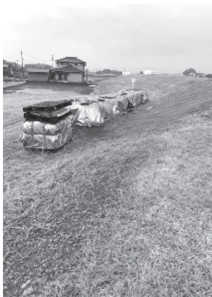
堤防下段に準備している土嚢
