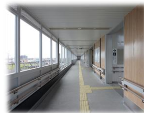
（駅自由通路改修事業）
