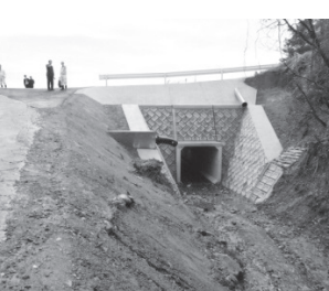
畑川水路の復旧状況
