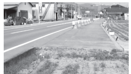
途切れた歩道
