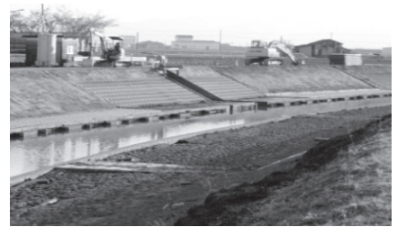
①平成28年度改修工事状況
