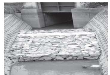
水とめコンクリート擁壁
