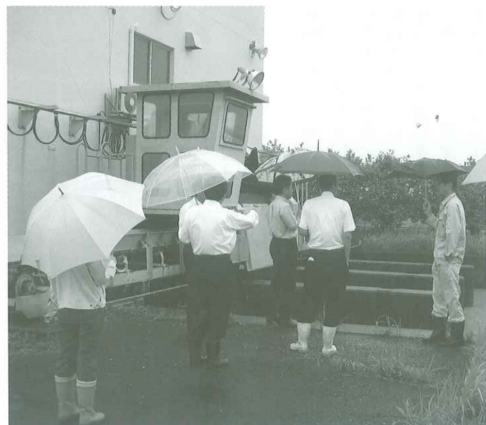
鳴江排水機場
