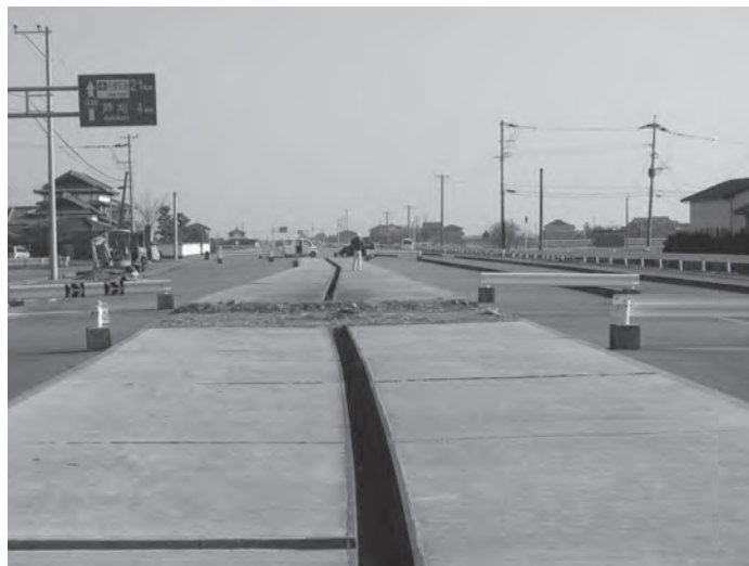
急ピッチで工事が進む県道江北・芦刈線バイパス
