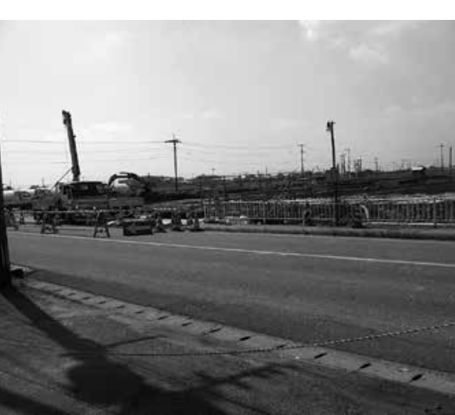
工事が進む町道門前～観音下線改築工事
