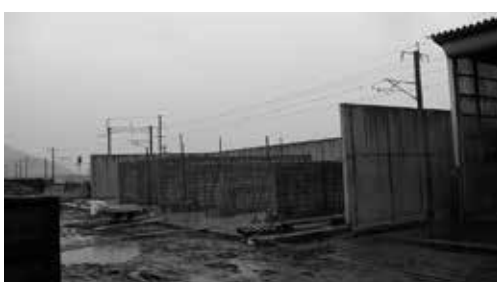
消臭施設の新設状況
