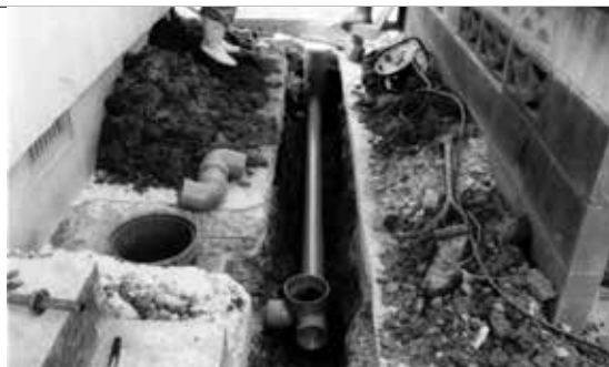
宅内接続工事状況
