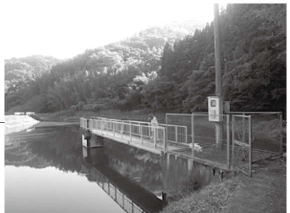
花祭上溜池、灌水施設 揚水ポンプ修理予定
