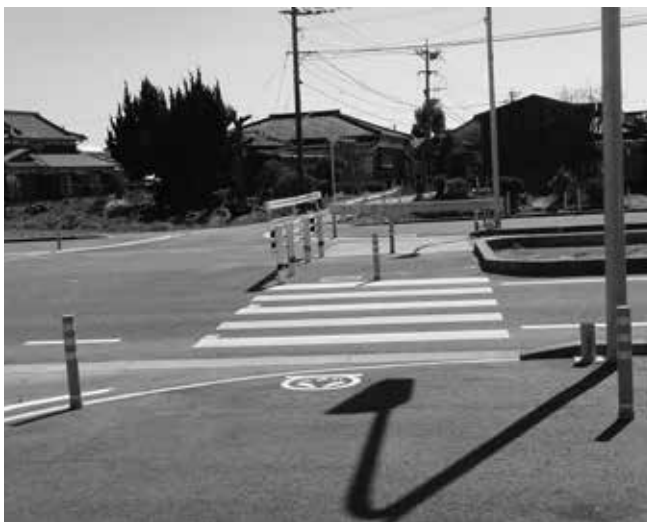
県道江北～芦刈線 小城市芦刈町の横断歩道設置状況
