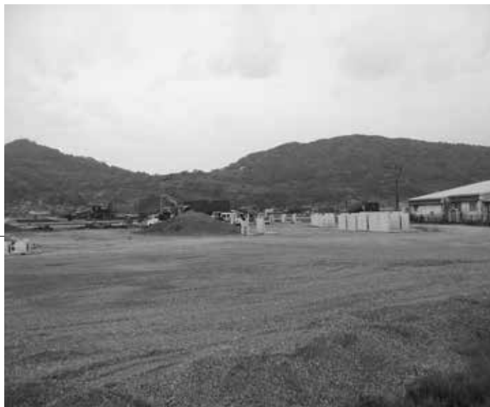
平成27年度完成に向け造成工事が進む町営住宅建設地
