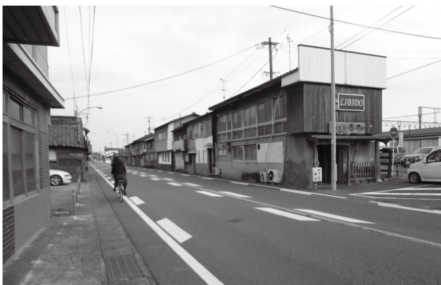
駅北側の危険個所、県道沿い歩道がない飲食街通り
