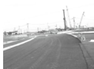
工事が進捗している 門前～観音下線
