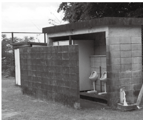
改修される高砂グランドトイレ
