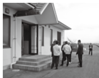
東分中継ポンプ場
