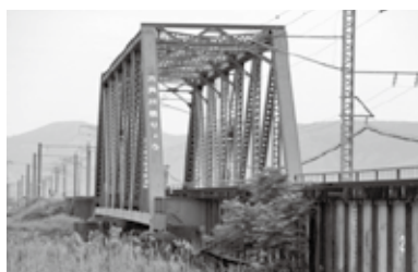
JR長崎本線六角川橋梁付近(大西)
