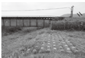
コンクリートブロックの状況
