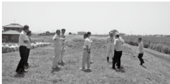
堤防高不足(1.2m)と土のう配置状況
