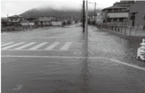
町道上分～羽佐間水路線 町道東分～祖子分線交差 道路冠水
