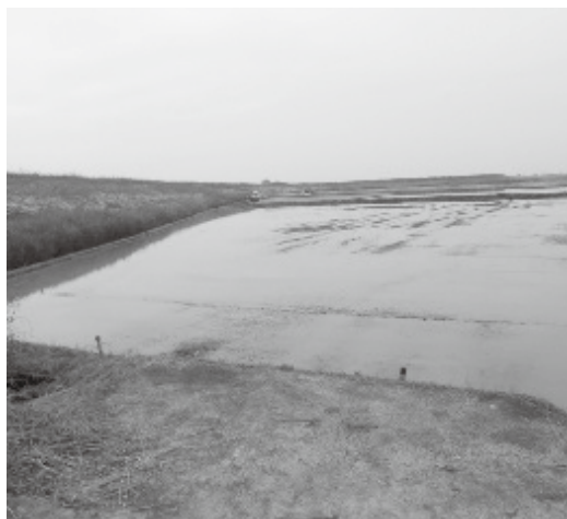
堤防側が沈下している水田
